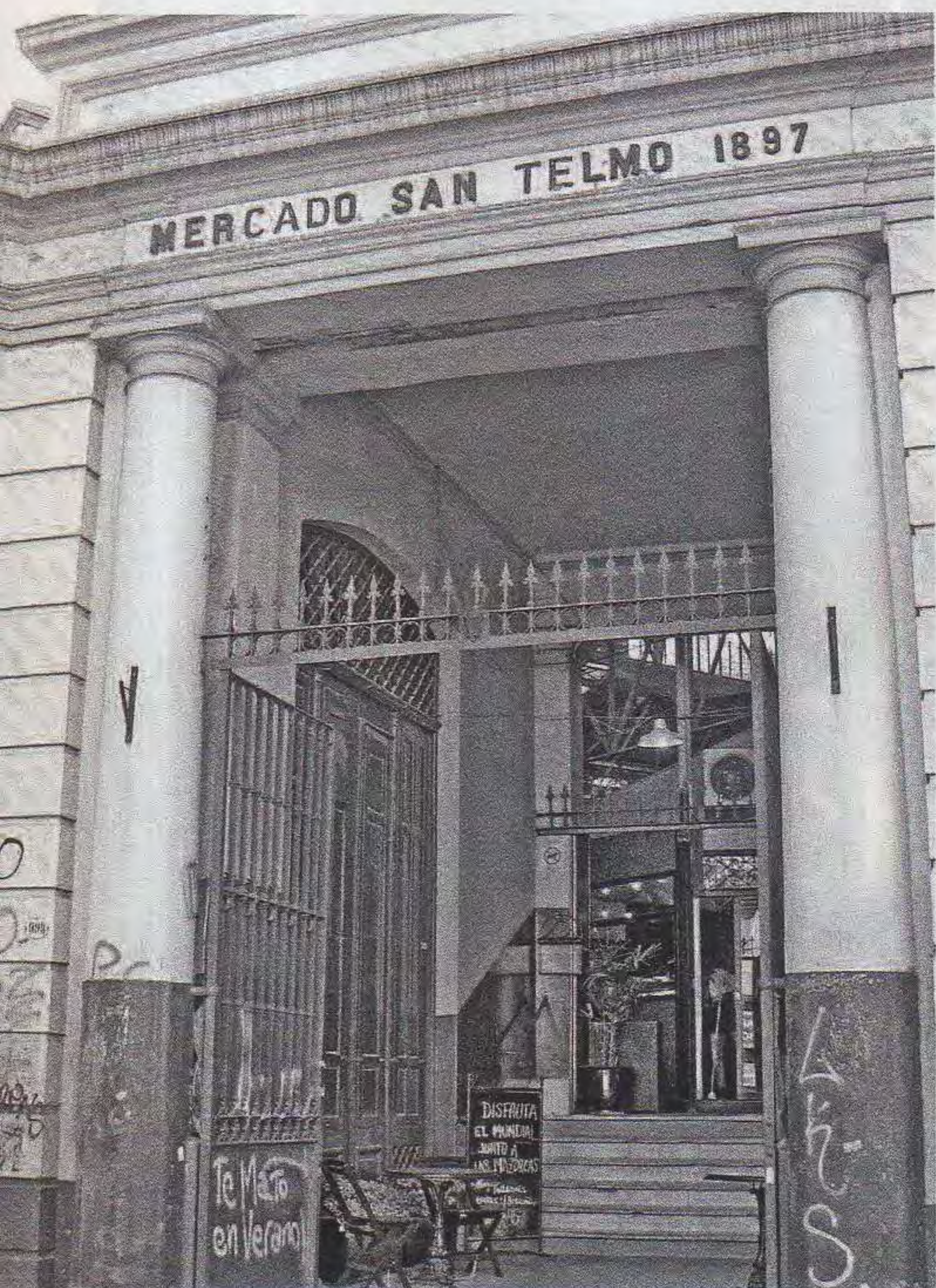
ENTRADA Y DETALLE DEL TECHO DEL MERCADO DE SAN TELMO, EN BOLÍVAR Y CARLOS CALVO.
