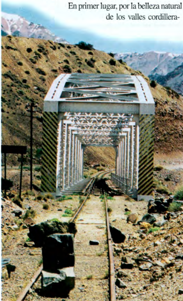
La vía y los puentes se encuentran en un estado sorprendentemente bueno pese a los años de abandono.
