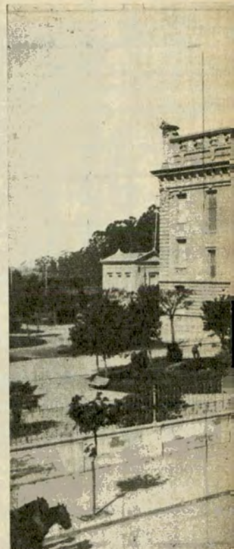
Edificio del Banco de
