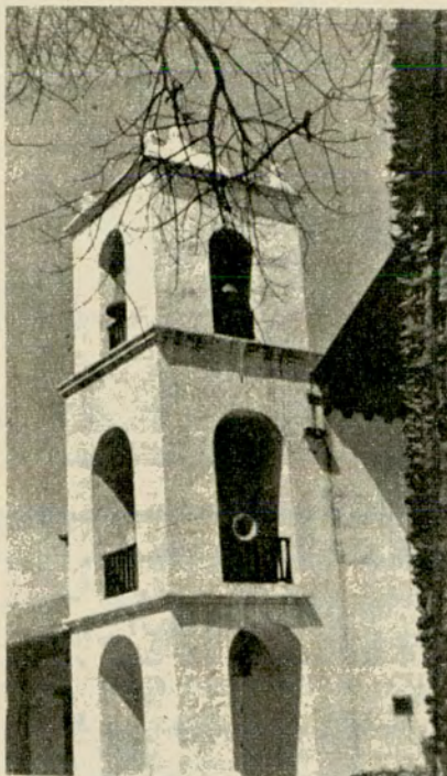
Campanario que guarda a " La Carachosa ", campana fundida por Javier de la Rosa.
