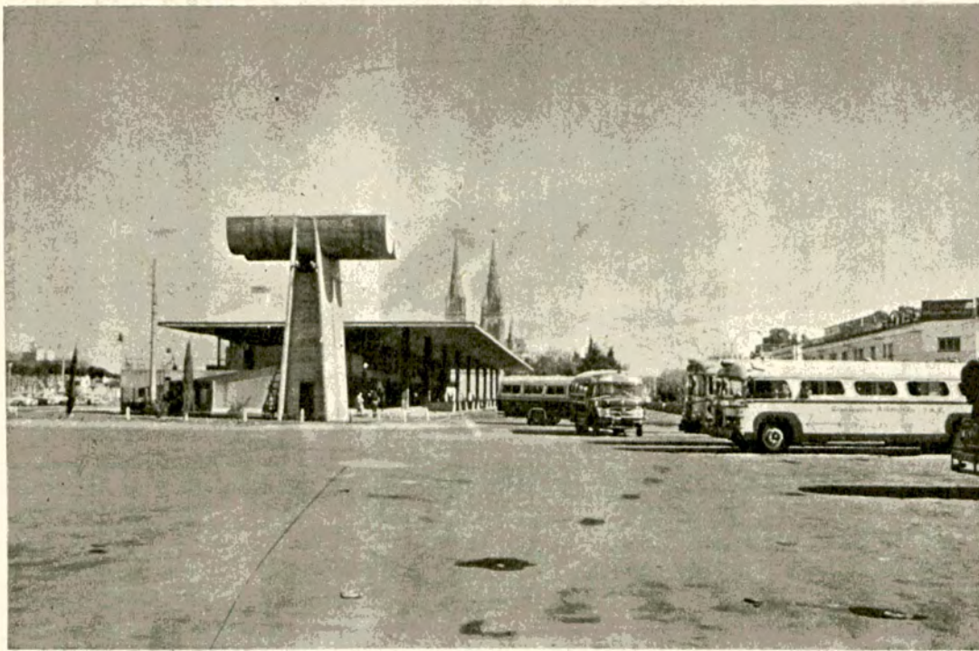
Abajo: Frente del edificio de la Municipalidad de la pujante ciudad bonaerense.
