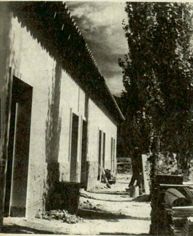
Aspecto parcial de la hostería del A.C.A. en Cachi, a habilitarse
