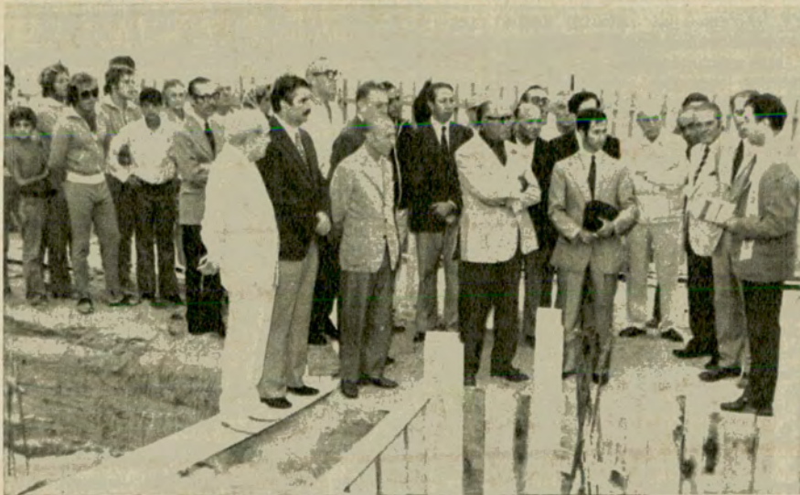
Autoridades comunales e integrantes de la delegación de la Entidad durante la bendición de la primera etapa de las obras realizada en Miramar.
