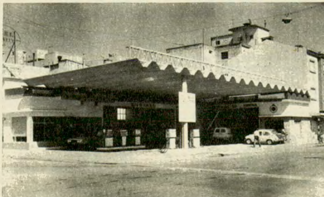
Estación de Servicio Alberti, en Mar del Plata.
