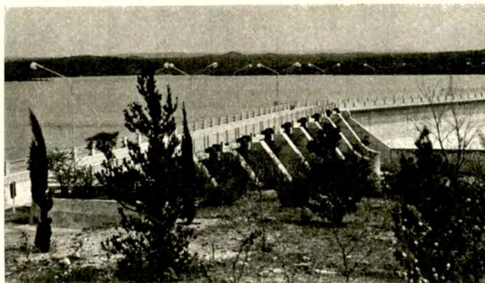
Dique Segunda Usina de Río Tercero.
