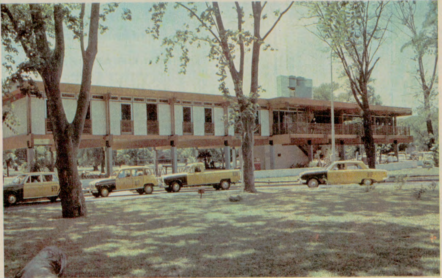
Frente del moderno edificio de la Escuela.
