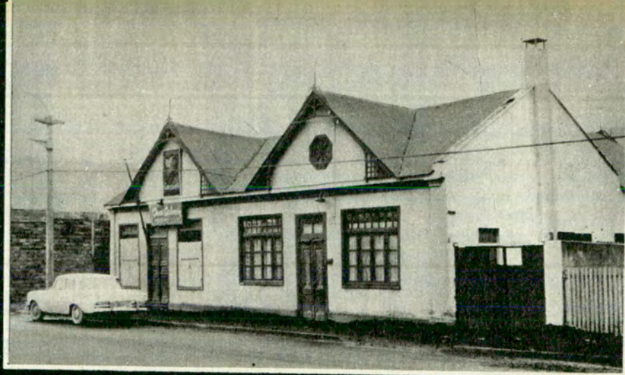
Casa de chapa y madera: un ejemplo del estilo que impera en la ciudad austral.
