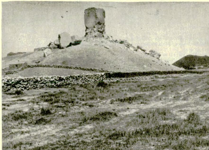
Detalle de la salida de Antofagasta de la Sierra, ya en Catamarca.
