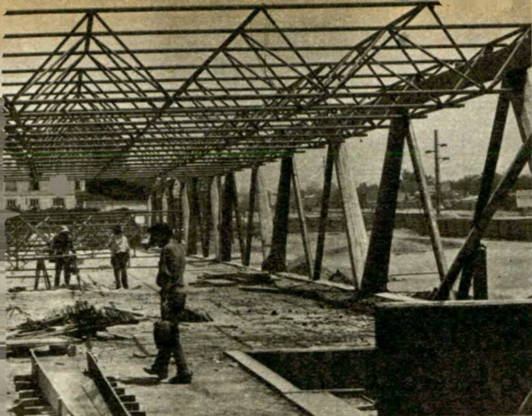
de la estructura metálica sobre la planta alta.
