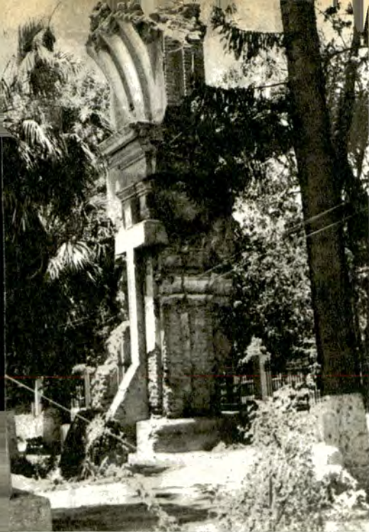
Restos en pie del terremoto que destruyó a Mendoza en 1861.
