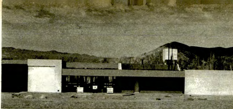
Parte de las instalaciones de la Estación de Servicio de Las Flores, en San Juan.
