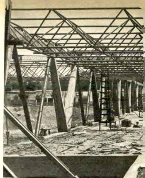
Obras finales de la colocación
