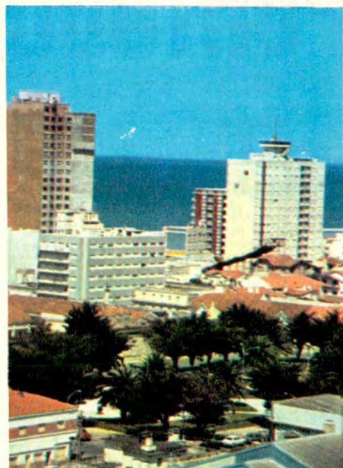
Vista parcial del gran balneario.
