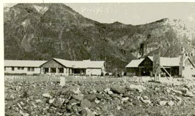
Estación y Motel de Barrancas (Neuquén)
