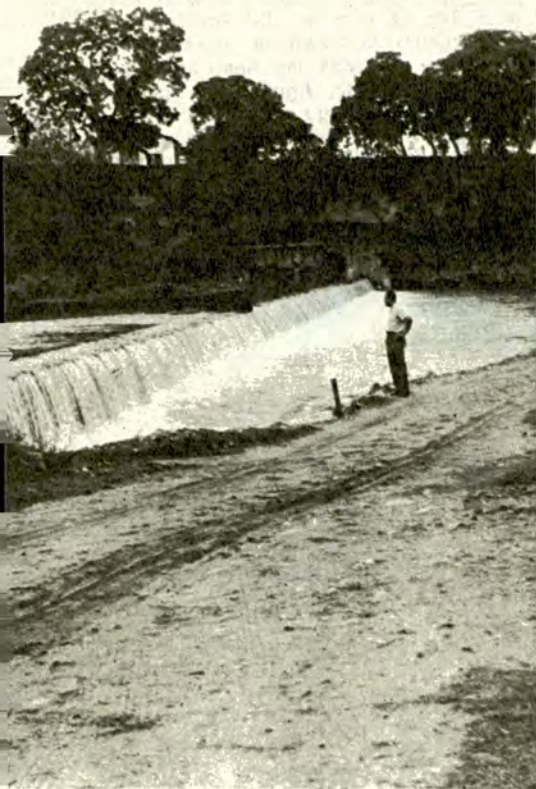
Dique nivelador del río Marapa, en la parte sur de la provincia.
