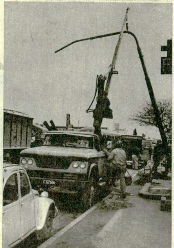
La instalación de las columnas se realiza mediante la utilización de una hidrogrúa.
