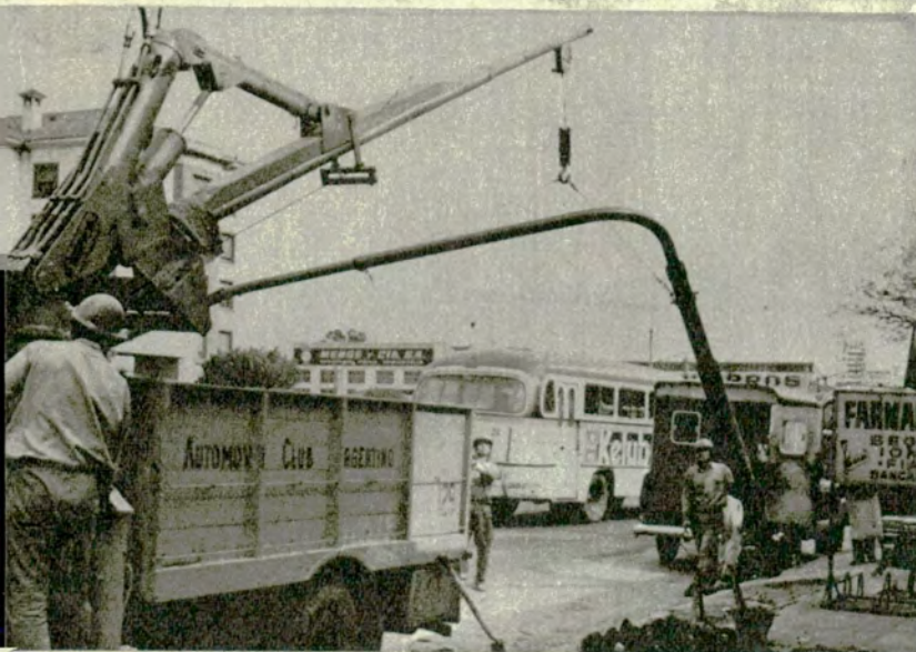
Personal especializado arma la columna metálica. El Automóvil Club Argentino colabora con los organismos de vialidad.
