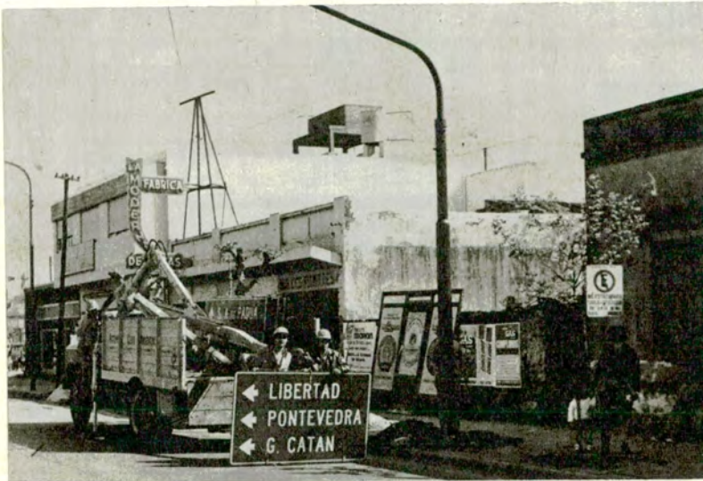
Ya ha sido emplazada la columna. El equipo especializado se apresta a colocar el cartel. El sistema se está instalando en las rutas nacionales de acceso a la Capital Federal números 1, 3, 7, 8, 201, 205 y en la ruta provincial 14.
