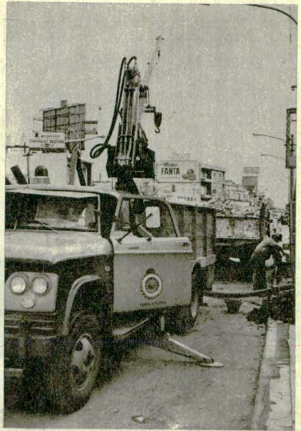
La instalación de las columnas se realiza mediante la utilización de una hidrogrúa.
