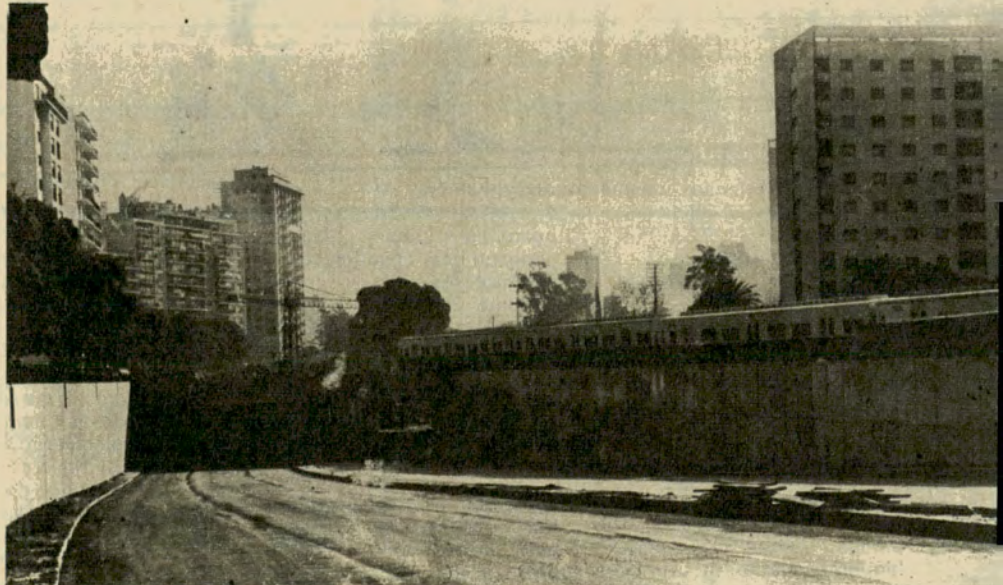
Obras en la Avenida del Libertador: cruce a bajo nivel en Belgrano.
