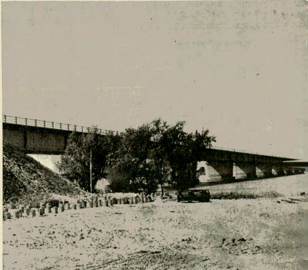
Puente sobre el río Colastiné, brazo del río Paraná que comunica con la isla El Timbo, en la que está la boca de entrada al túnel subfluvial Hernandarias.
