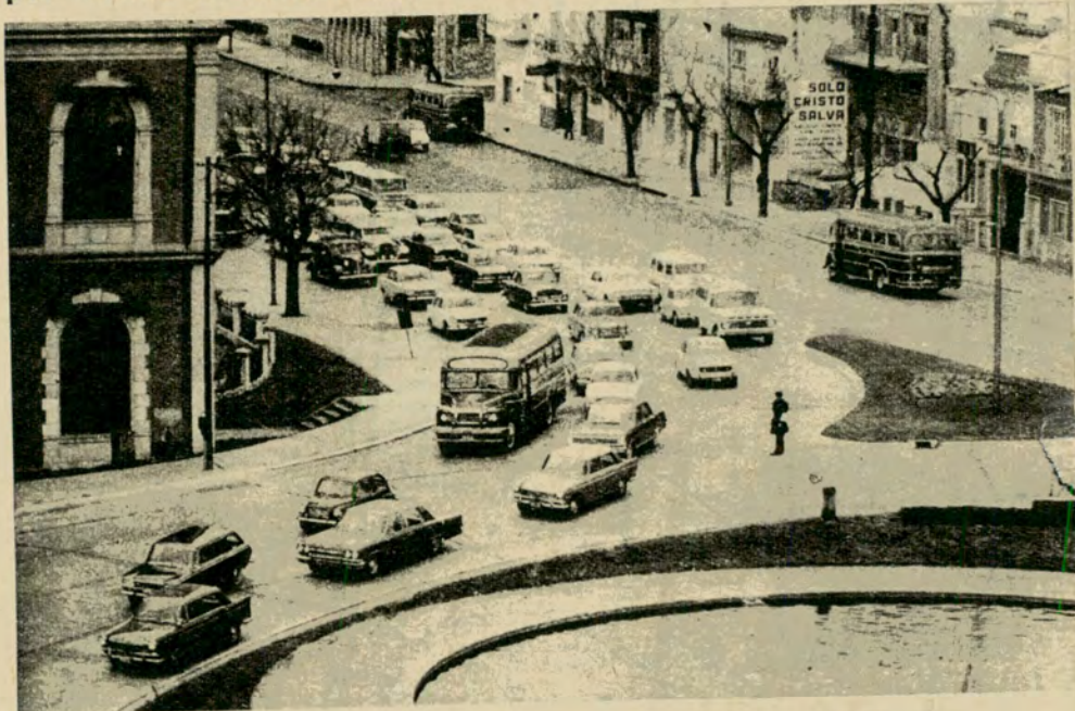
La falta de señales adecuadas es causa de numerosos accidentes de tránsito.
