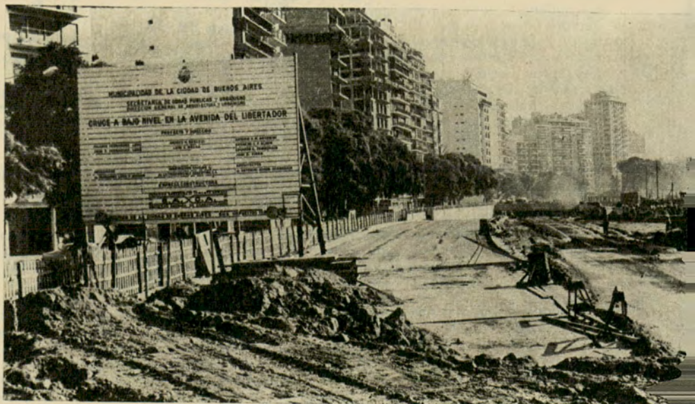
Aspecto general de la construcción del túnel. La ciudad se moderniza.
