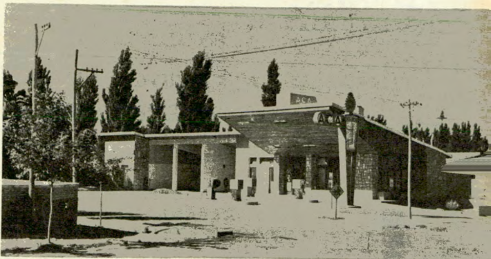
Vista de la estación caminera de Chos Malal en la provincia de Neuquén.
