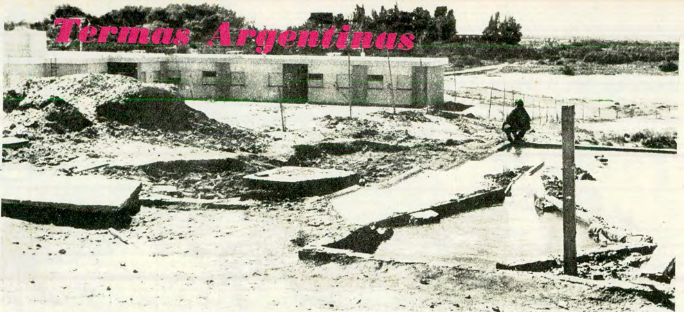
Aspecto del contrafrente del establecimiento termal de Pedro Luro, enfocado desde la perforación realizada por la Dirección de Minería y Geología en 1941.
