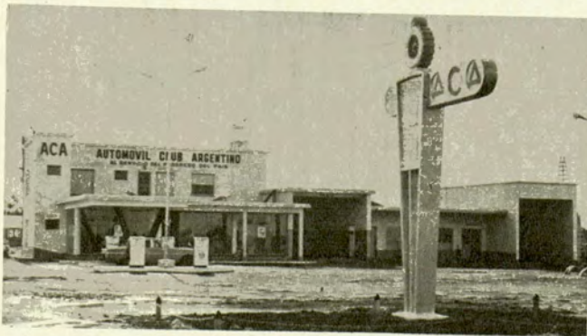
Frente de la flamante estación de servicio de la localidad de San Cayetano, en el sur de la provincia de Buenos Aires.
