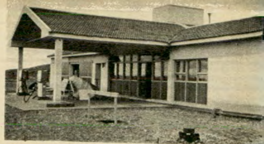
Vista parcial de la estación de servicio del Automóvil Club Argentino construida en el estratégico lugar llamado "La Laurita", sobre la ruta nacional N° 40.
