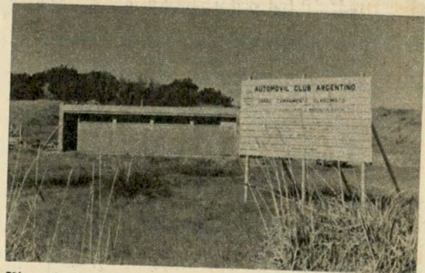
Vista de las obras que realiza el A.C.A. en Claromecó.
