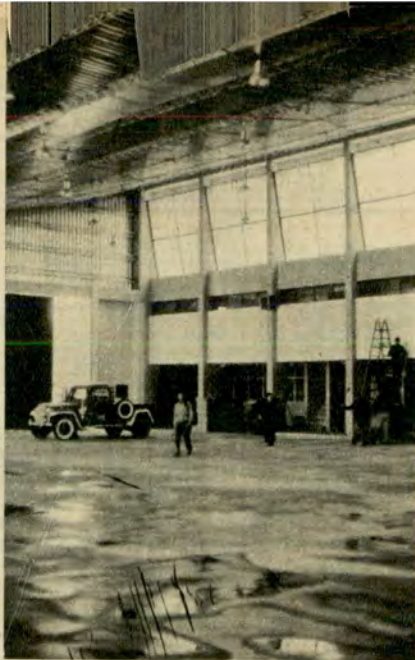
Aspecto parcial de los talleres mecánicos y playa de estacionamiento cubierta para los vehículos en servicio.
