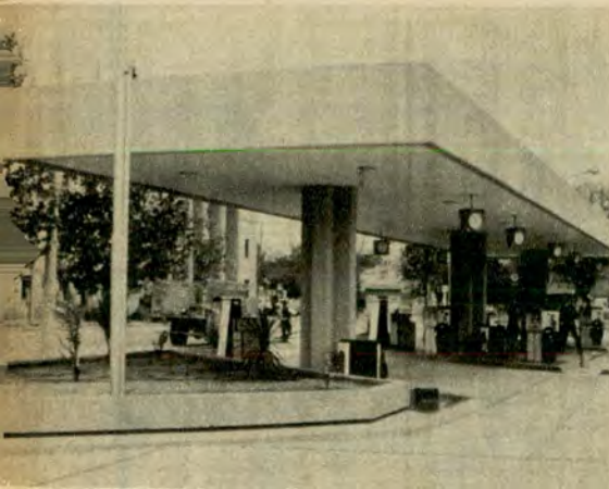
Un primer plano que enfoca la playa de surtidores en el sector cubierto, con las instalaciones accesorias de aire, agua, etc.
