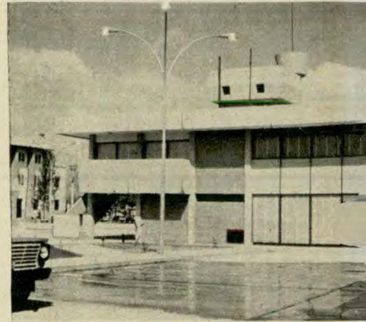
Vista posterior del edificio principal que es ocupado por la sede de la Filial San Juan y por las oficinas del Club.
