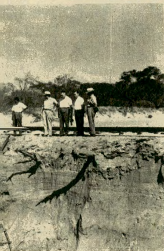
Obreros trabajando en el hundimiento de cilindros de hormigón armado, para base del puente que se levantará sobre el río Florida.
