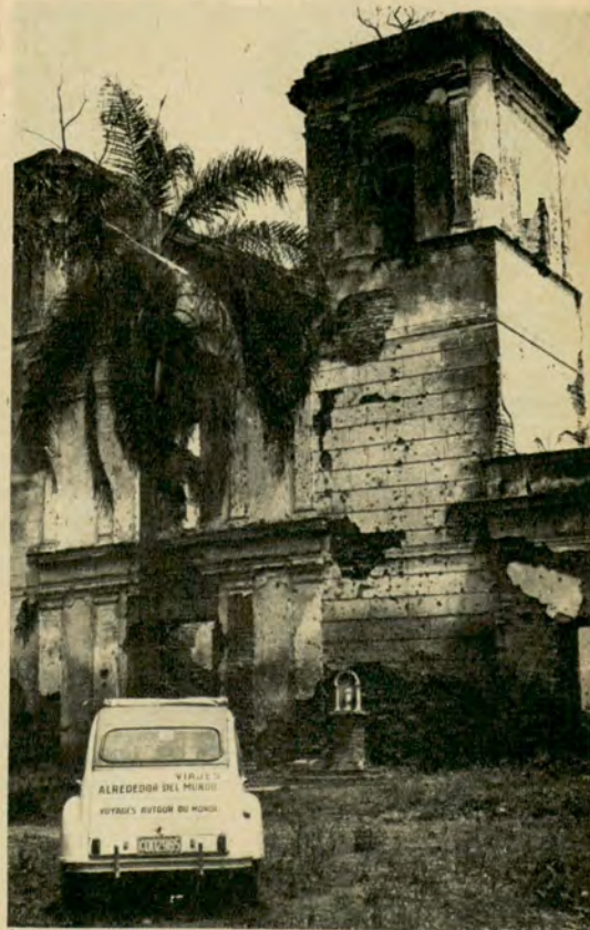
Los que visitan la Quebrada de Lules en Tucumán, hacen un alto ante las ruinas jesuíticas de la Capilla de San José, construcción que data del siglo XVII.
