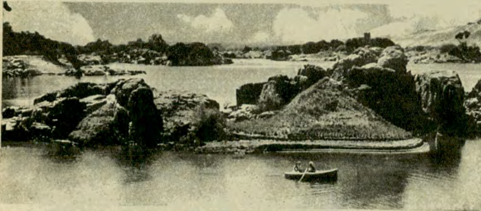
El Nilo, en la zona de Assuán, presenta un nuevo lecho excavado en la tierra y la roca, para dar lugar a la construcción de la gigantesca represa.
