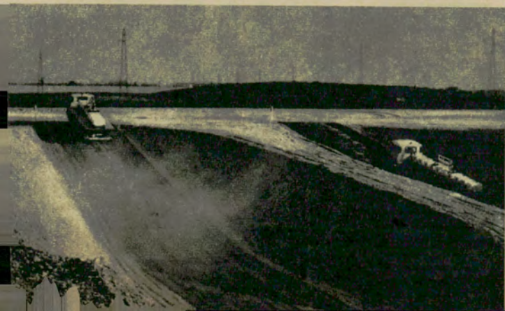
Fuertes rampas construidas en la pista de pruebas de la fábrica de Bourg-en-Bresse, sirven para demostrar la capacidad de tracción del camión Berliet.
