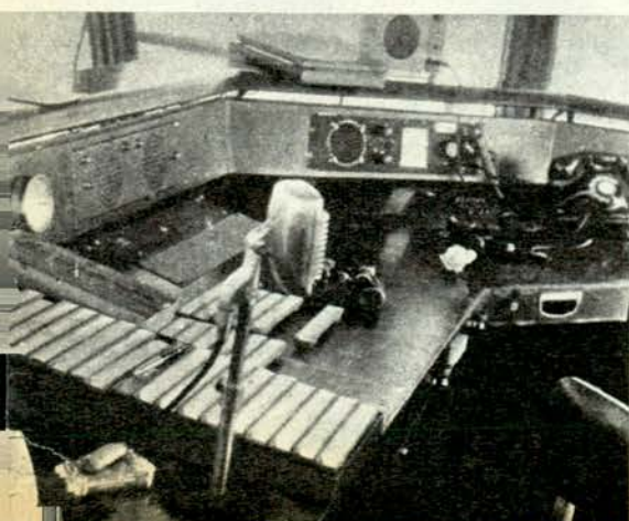
Dos de los tres sectores de la cabina. A la derecha los tableros que comunican con Ezeiza. A la izquierda un micrófono, relojes, fajas de vuelo y el infaltable cigarrillo.
