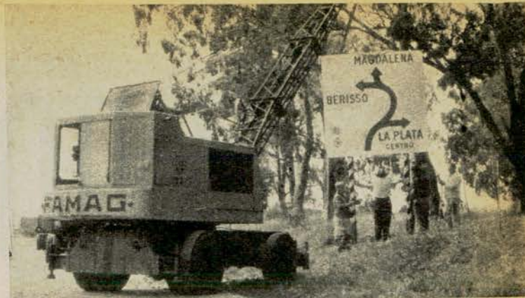
La fotografía permite apreciar, por comparación, las dimensiones de una de las señales instaladas en La Plata, para cuyo emplazamiento fue necesario recurrir a los servicios de una grúa.
