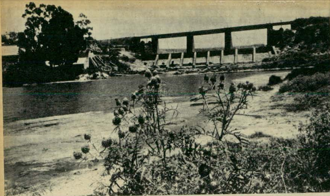
Puente ferroviario sobre el Río Quequén Salado, que une los pueblos Oriente y Copetonas. Reemplazó al que fue arrasado por la gran creciente de 1919, cuyos restos pueden verse en el lecho del río.
