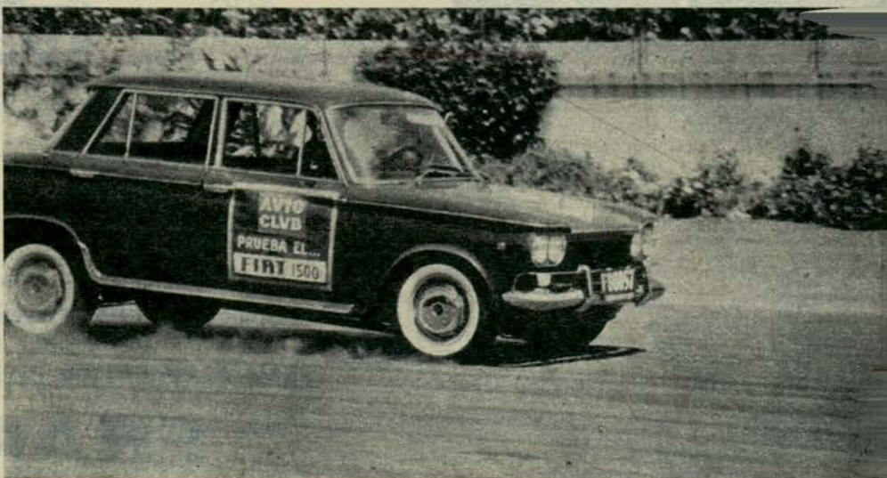
En la prueba de frenaje el coche se detuvo en un metraje razonable y sin desplazamientos laterales. Según comentarios de los fabricantes, los nuevos modelos poseerán un servo que ayudará y mejorará notablemente la acción de los frenos.
