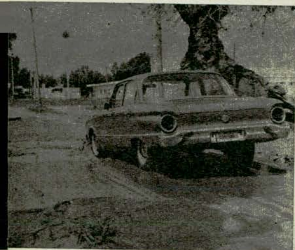
El pavimento roto y abandonado es una permanente valla que se opone al paso de los automóviles.
