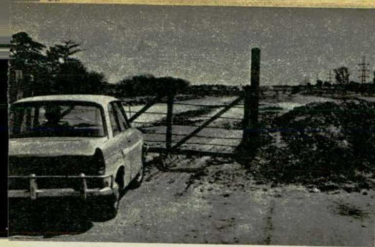
Detrás de esta tranquera hay cuatro kilómetros de Acceso Norte ya terminados. Porque no se los habilita, los conductores tienen que hacer un verdadero vía crucis para salir de la Capital por esa zona.
