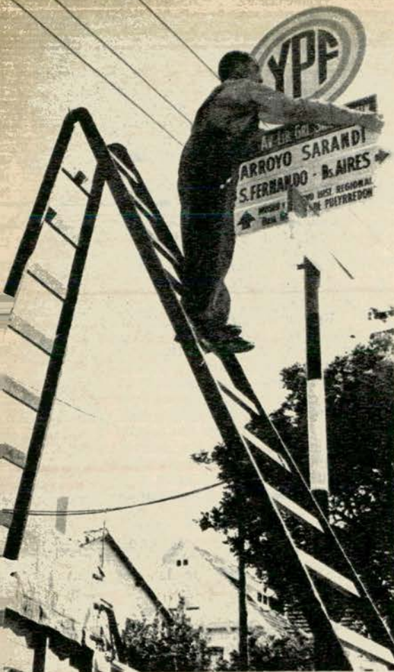
El A.C.A. tiene a su cargo la conservación de las señales por él colocadas. En la foto, un operario reacondiciona una señal que había sido deteriorada por la acción de los vientos.
