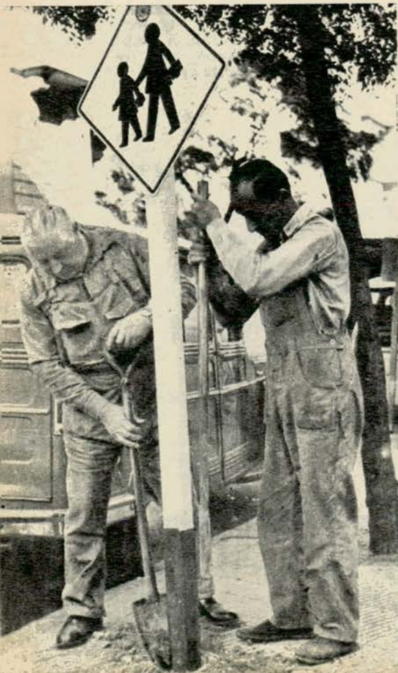
El A.C.A. tiene a su cargo la conservación de las señales por él colocadas. En la foto, un operario reacondiciona una señal que había sido deteriorada por la acción de los vientos.
