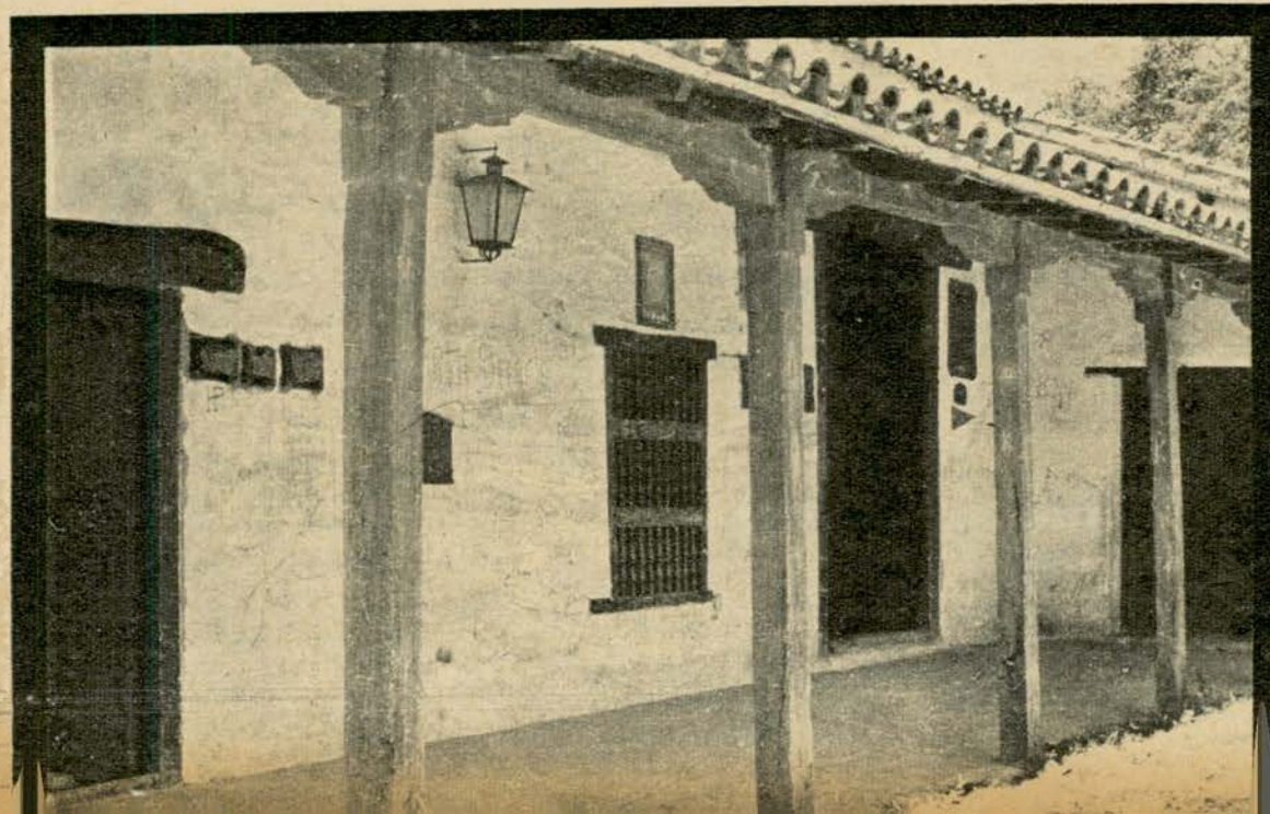
Detalle de la galería cubierta, sostenida por vigas de olgarrobo. Nada en Yatasto ha escapado a la irreverencia de los turistas. Todo está materialmente cubierto por inscripciones.
